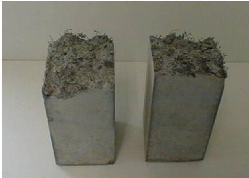
コンクリート破断面
